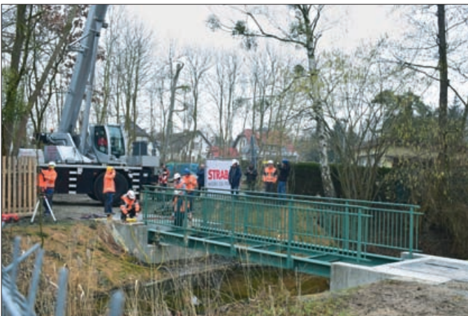
Neue Stahlkonstruktion für die Heuwegbrücke (Foto: K. Brandau)
