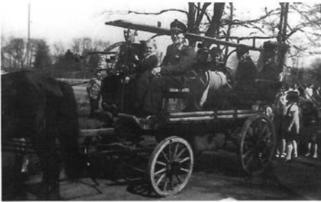
Mannschaftshanddruckspritze - Pferdebespannt Mindestens 4 Mann werden zum Pumpen benötigt
