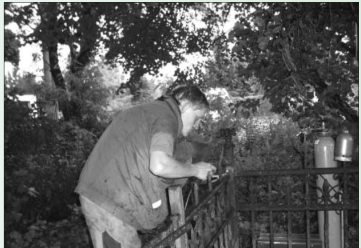
Steve Peglow bei der schweißtechnischen Instandsetzung der inneren Grabstätten-einfriedung.
