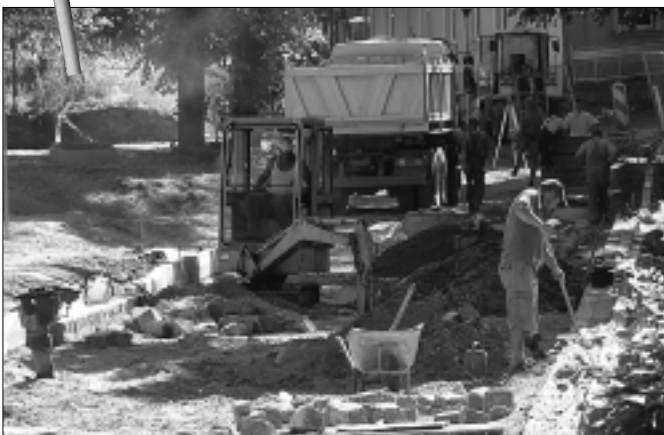
Trotz brütender Hitze verlaufen die Arbeiten planmäßig.
