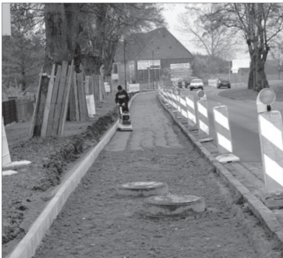
Kombinierter Geh- und Radweg verbindet Altstadt mit Scheunenviertel.
